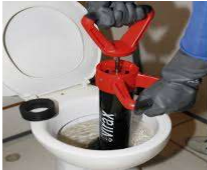
(Débouchage de WC)
