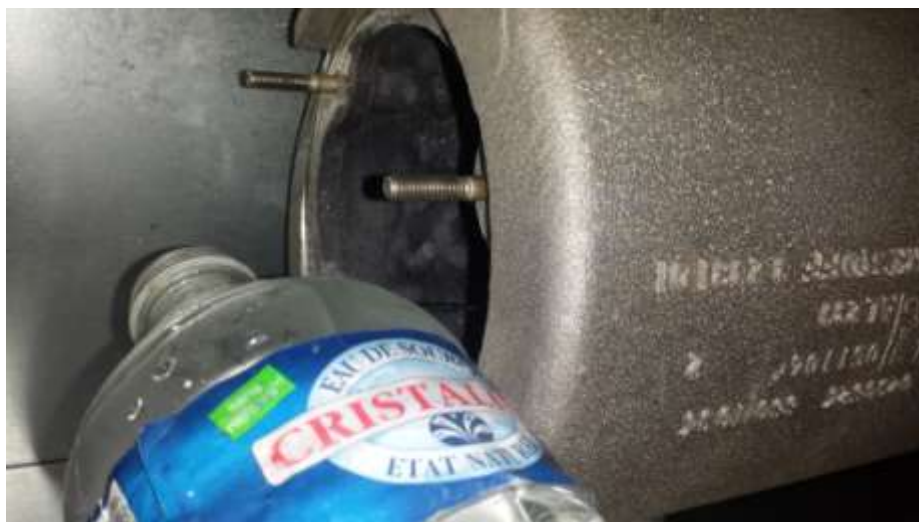
(Rinçage du bruleur à l'aide d'une bouteille)
